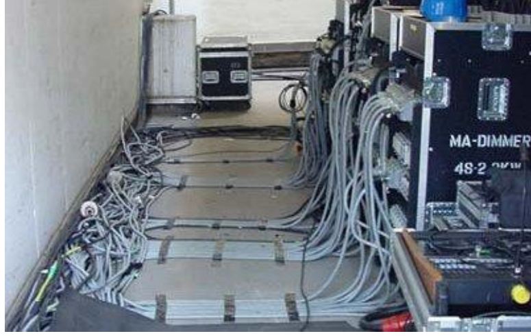
Resim 2.10: Dimmerler ve dimmer odası
